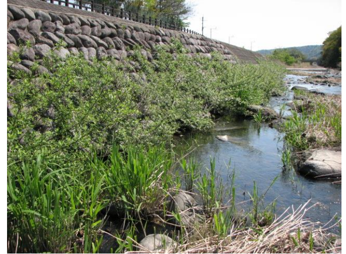
平成23年6月 施工後2年
