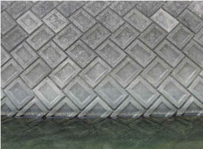
二見川（熊本県八代）平成22年3月施工
