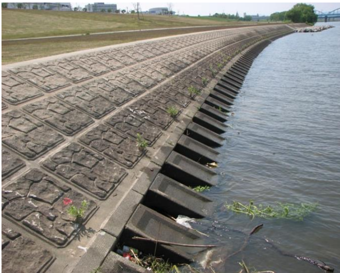
筑後川（福岡県久留米市）平成21年3月施工
