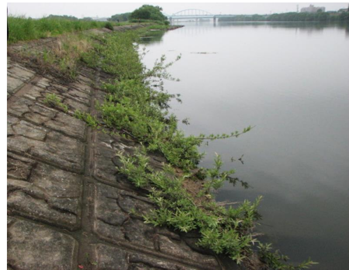
平成22年6月 施工後1年
