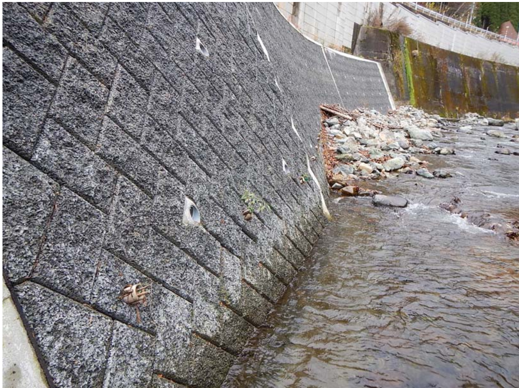
写真一No.34 揖保川 山崎地区の右岸側の植栽状況 2013.3 施工（半年経過）撮影日：2013.11.28（国土交通省姫路河川国道事務所） 注）水衝部に位置するため、洪水の都度に枝葉が損傷し成長不良となり、一部枯死がみられる。（写真奥、水制工も損傷している）。
