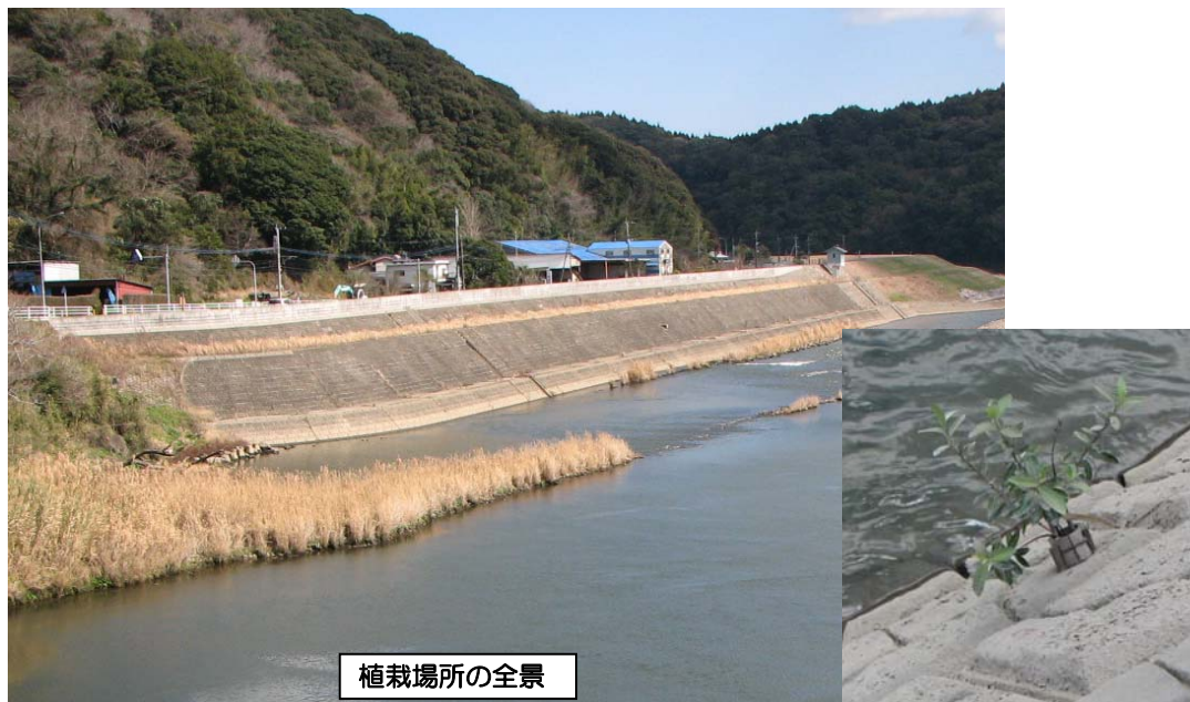
写真—No.30 大淀川 日高地区の左岸側の植栽場所と新枝葉の状況 2013.2 施工（半年経過） 撮影日：2013.09.13（国土交通省宮崎河川国道事務所）
