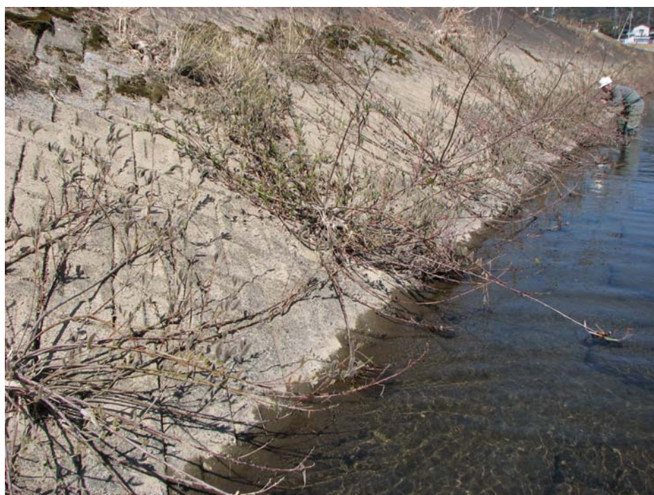
写真一No.15 五ヶ瀬川（天下地区その1） 左岸側の花穂時の状況 2011.3 施工（3 年経過）撮影日：2014.03.11（国土交通省延岡河川国道事務所）
