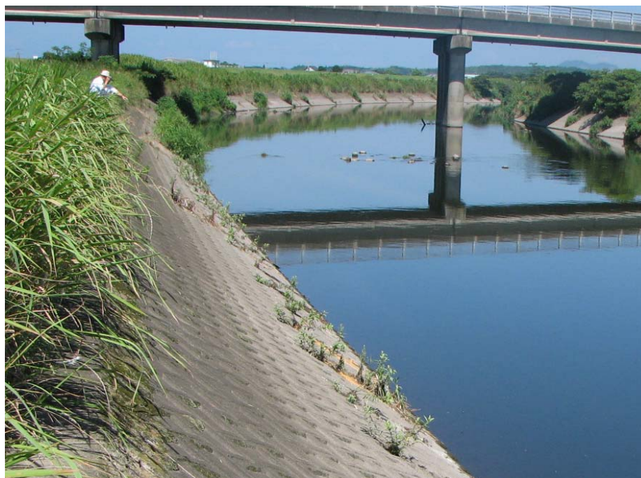
写真—No.31 肝属川 宮下地区の左岸側の成長状況 2013.3 施工（五か月経過） 撮影日：2013.07.17（国土交通省大隅河川国道事務所）
