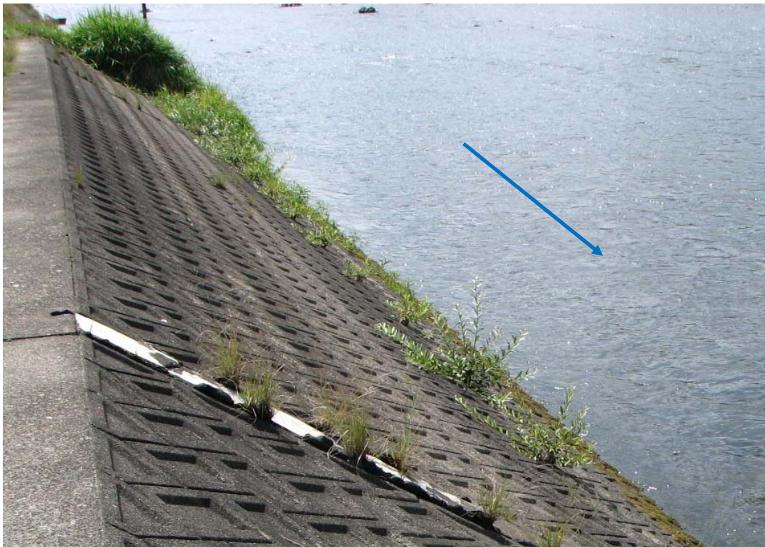
写真一No.26 球磨川 人吉市内右岸側護岸の成長状況 2011.2 施工 (2年経過) 撮影日: 2013.05.20 (国土交通省八代河川国道事務所)
