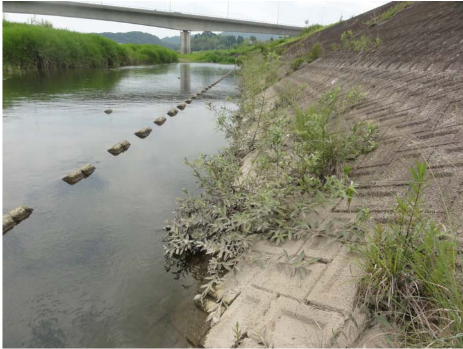
写真一No.32 五ヶ瀬川（天下地区）左岸側の成長状況 2013.3 施工（3 か月経過） 撮影日：2013.06.18（国土交通省延岡河川国道事務所）
