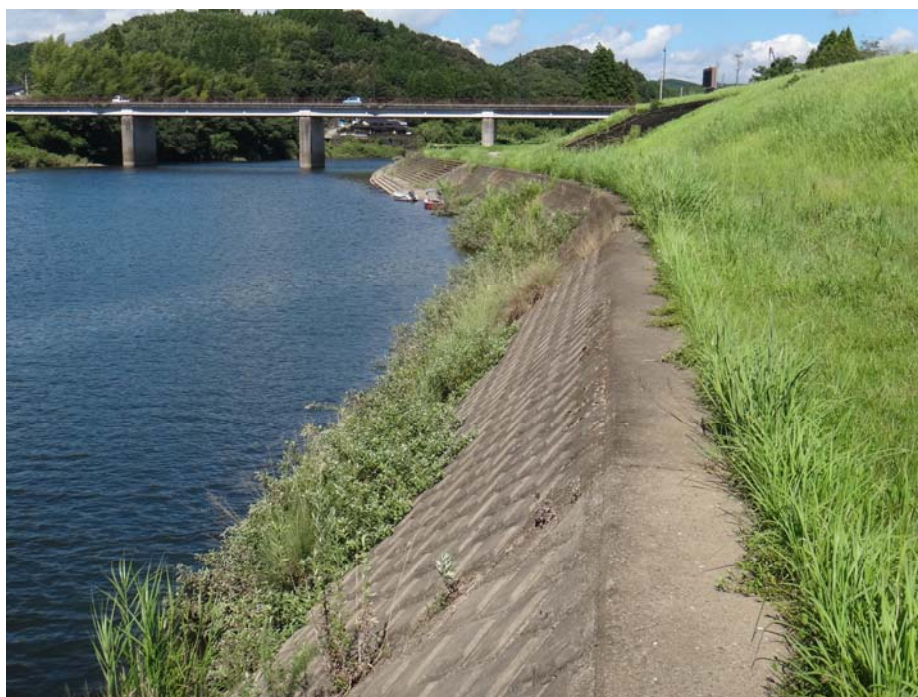
写真一No.6 の2 川内川 鶴田地区左岸側護岸の繁茂状況 2010.3 施工（3 年経過）撮影日：2013.07.22（国土交通省川内川河川事務所）
