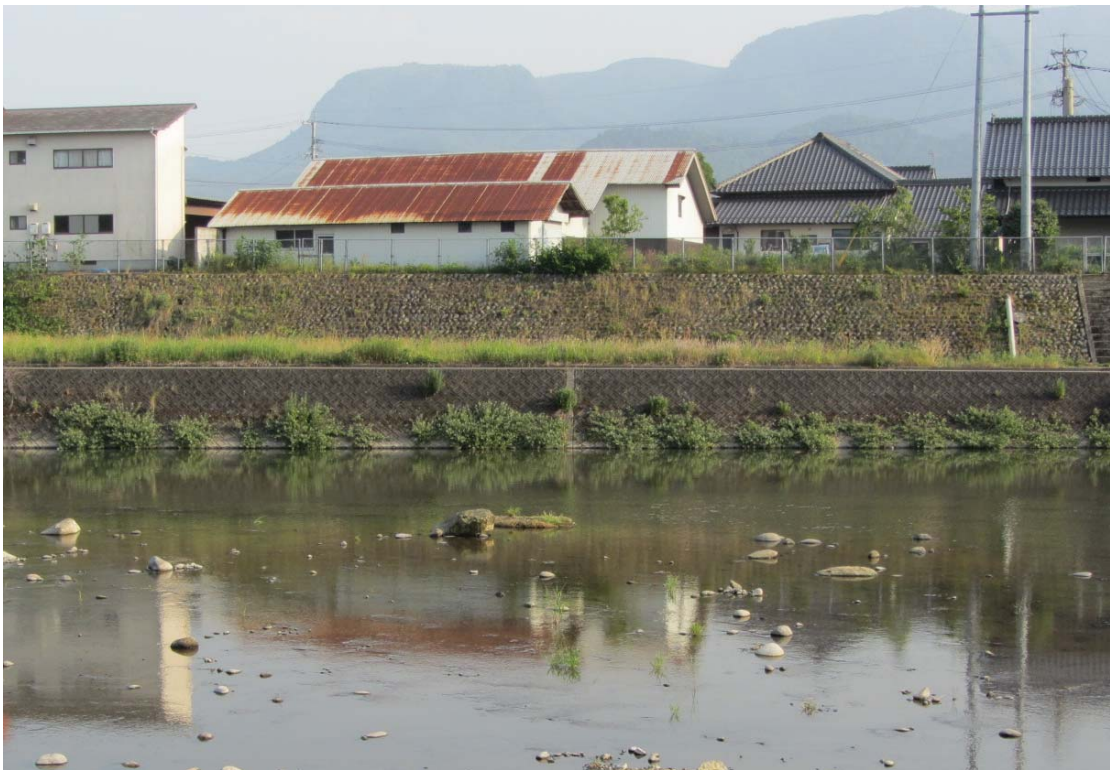
写真一No.28 筑後川水系玖珠川 協心橋上流左岸側の繁茂状況 2012.3 施工（2年経過）撮影日：2014.05.30（大分県玖珠土木事務所）
