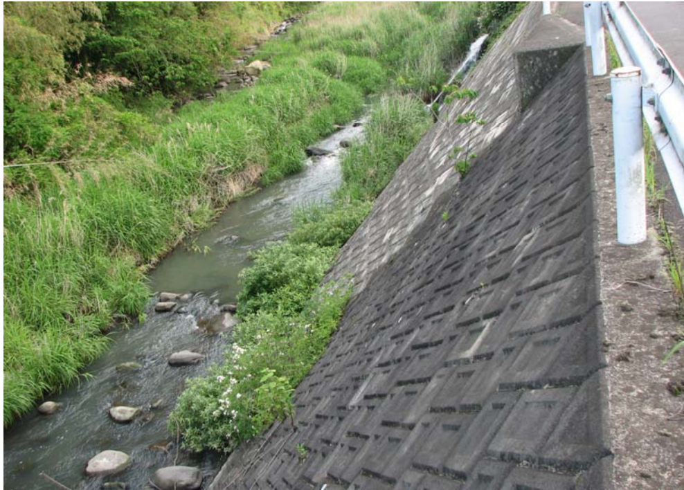
写真一No.12 大分川水系由布川（来鉢地区）左岸側の繁茂状況 2010.3 施工（3年経過）撮影日：2014.05.21（大分県由布市役所）
