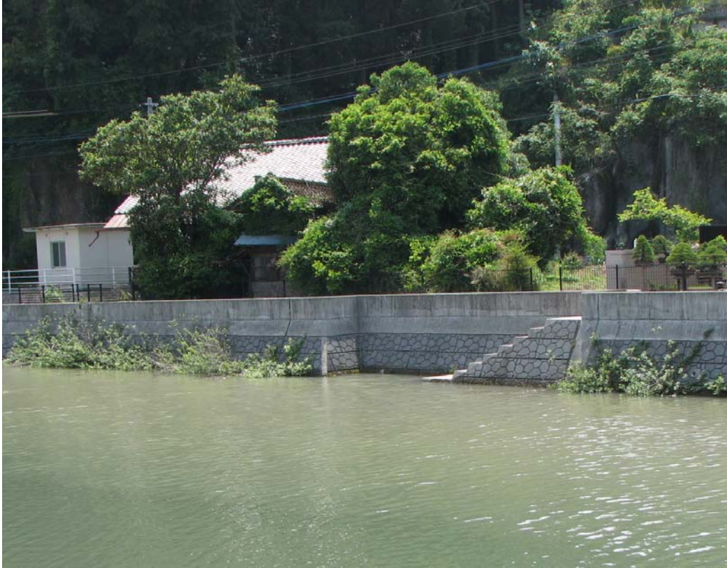
写真一No.22 大野川水系酒井寺川 右岸側の繁茂状況 2011.2 施工（3年経過）撮影日：2014.05.21（大分県豊後大野土木事務所）
