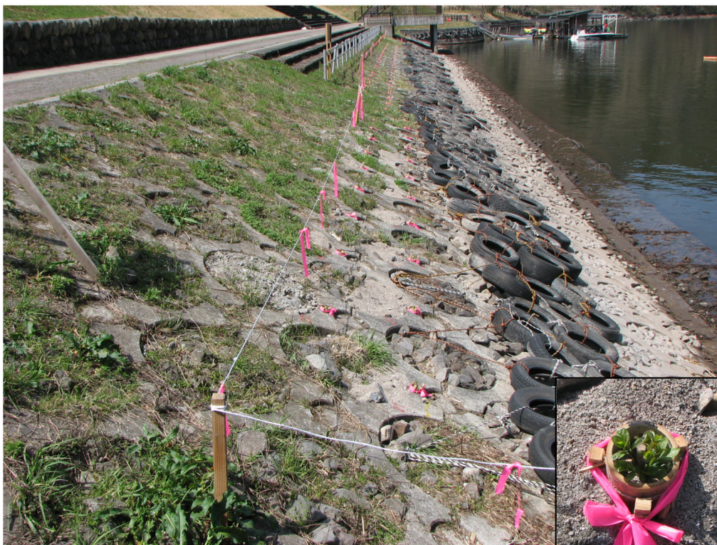
写真一No.42-2 山国川耶馬溪ダム 既設護岸（連結ブロック）緑化 2015.3 施工 撮影日：2015.4.2
