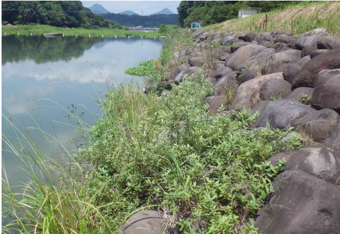
写真一No.18 駅館川水系津房川 右岸の繁茂状況 2010.4 施工（3年半経過）撮影日：2013.08.06（大分県宇佐土木事務所）
