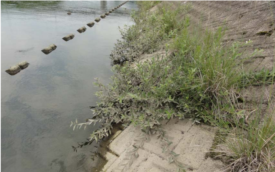
写真一No.25 五ヶ瀬川 (天下地区) 左岸側の成長状況 2011.3 施工 (2年経過) 撮影日: 2013.06.18 (国土交通省延岡河川国道事務所)
