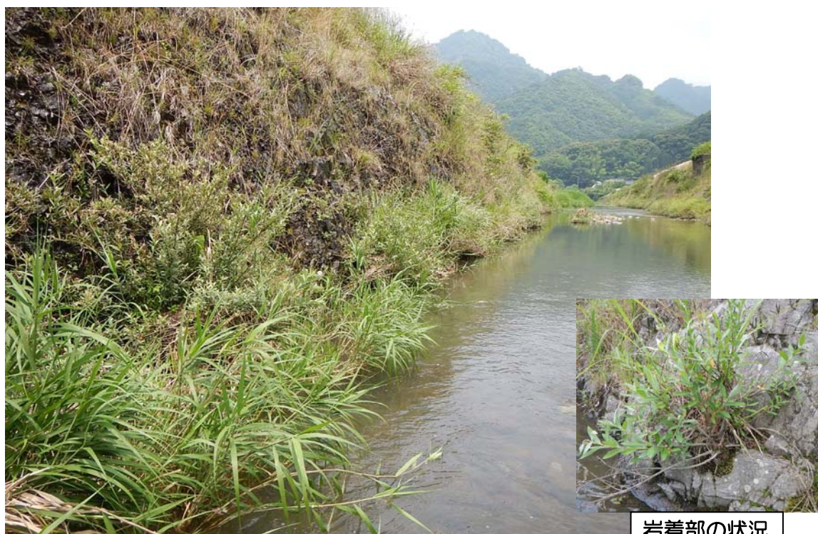
写真-No.4の1 山国川水系西谷川 軟岩のり面に対する植栽・繁茂状況
