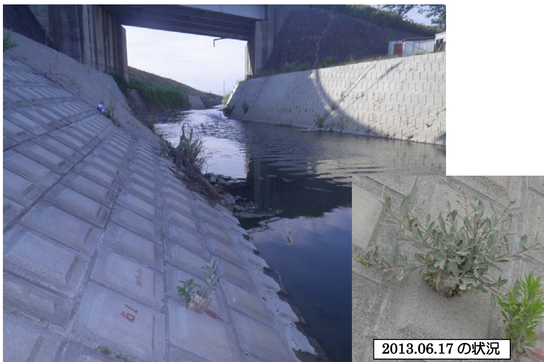
写真一No.36 富士川水系八系川 試験植栽 2013.2 施工（3 か月経過）（山梨県中北建設事務所）
