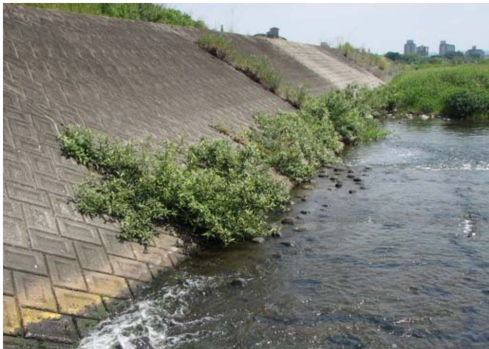
写真一No.14 大分川水系賀来川 左岸（大分川合流点）の繁茂状況 2010.5 施工（1 年経過）撮影日：2011.08.31（国土交通省大分河川国道事務所） 注）この後の洪水流や土砂堆積により大きく損傷したが、その後、回復している。
