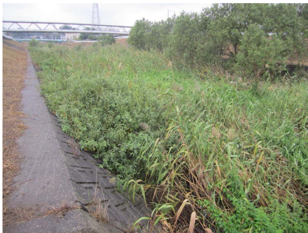
写真一No.8 遠賀川水系黒川 香月地区左岸側護岸の繁茂状況 2010.3 施工（3年経過）撮影日：2013.10.07（国土交通省遠賀川河川事務所）
