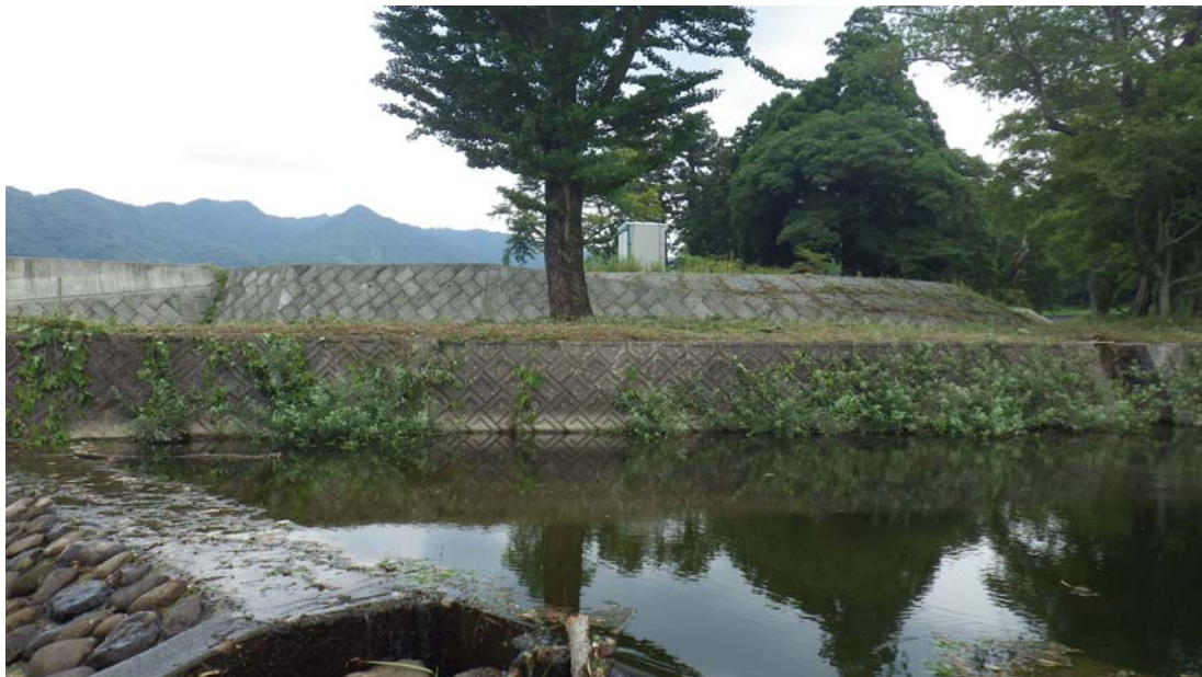
写真一No.20 二級河川桂川（田染真中地区）右岸側の繁茂状況 2011.3 施工（2年経過）撮影日：2013.08.05（大分県豊後高田土木事務所）
