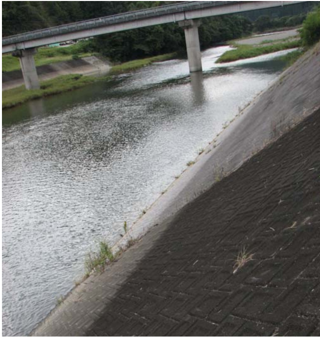
植栽箇所全景
