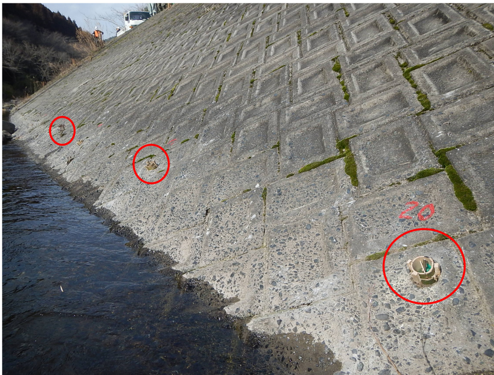
写真一No.42-2 山国川耶馬溪ダム 既設護岸（連結ブロック）緑化 2015.3 施工 撮影日：2015.4.2
