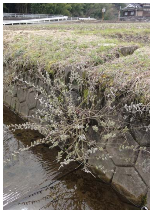
水路植栽の花穂の状況 2013.3 施工（1 年経過） 撮影日：2014.03.02
