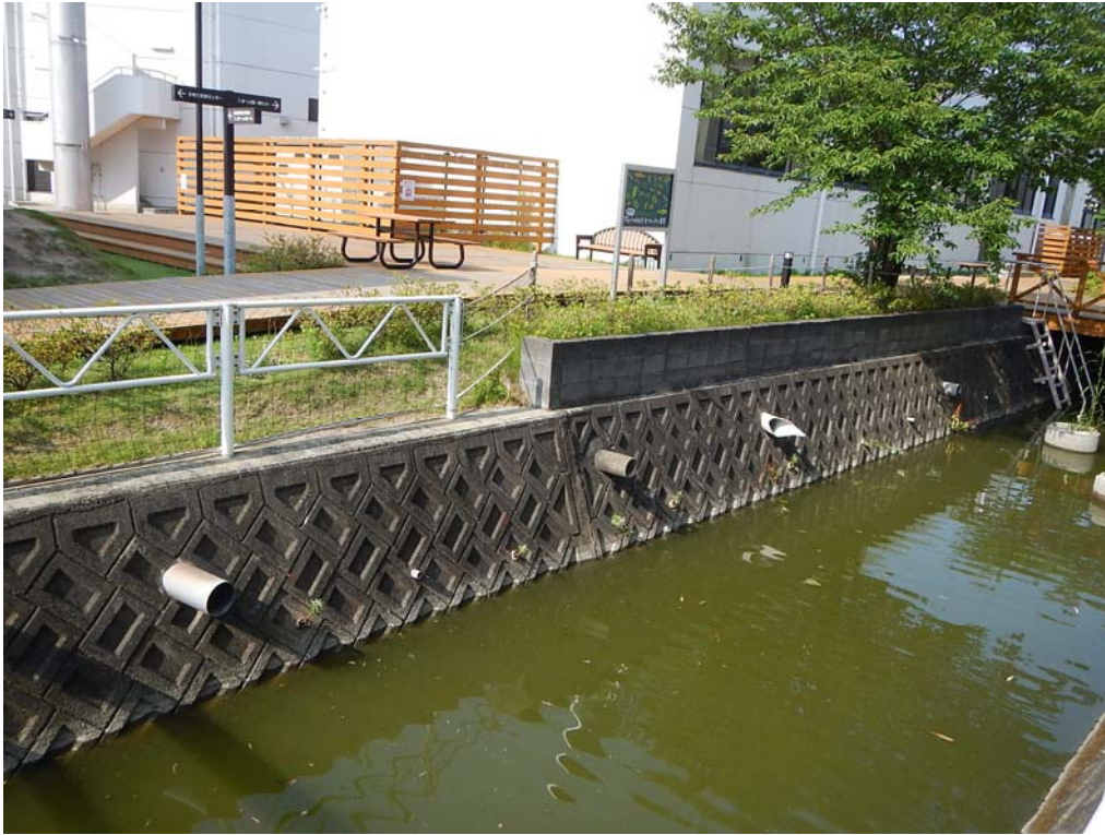
写真一No.40 大木町庁舎内水路の護岸植栽試験 2014.3 施工（3 か月経過） 撮影日：2014.06.13（福岡県大木町役場）
