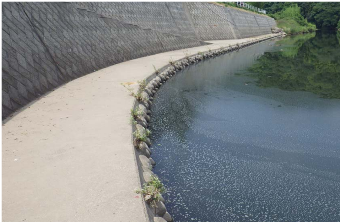
写真一No.11 二級河川桂川 小田原地区左岸側の繁茂状況 2010.3 施工（3年経過、再植栽から1年経過）撮影日：2013.08.05 （大分県豊後高田土木事務所）
