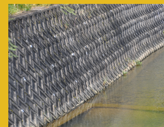
無機質なコンクリート護岸
